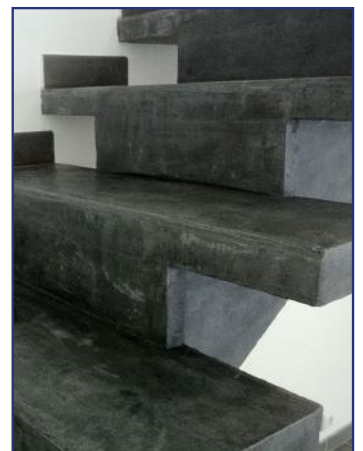
FINITION BÉTON CIRÉ
