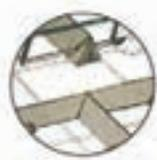
c) Couper les joints perpendiculaires à 30° pour assurer un bon emboîtement et éviter le recouvrement du béton sur l'intersection. Placer les plots béton à au moins 30 cm de l'intersection.
