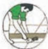
a) Posez des plots de béton espacés de 70 cm environ Ils servent à maintenir la règle. Mettre de niveau et contrôler l'alignement au cordeau.
