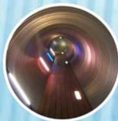
Les tuyaux SPIREL® permettent de réaliser des passages inférieurs entre 2 bâtiments. L'aménagement est facile et apporte un design original à la structure. Les diamètres fabriqués par Tubosider autorisent des passages piétonniers.
