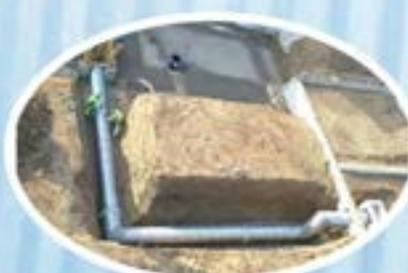
Les tuyaux SPIREL® sont une alternative économique pour la réalisation de gaines de ventilation ou de désenfumage par rapport à des solutions traditionnelles (carneau béton, ...). Les pièces fabriquées sur mesure s'adaptent à tous types de configuration technique. Notre acier galvanisé à chaud de qualité MO a une excellente résistance au feu.
