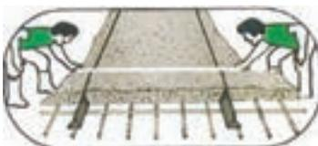
d) Aligner le béton avec une règle plate en suivant le sommet des joints
