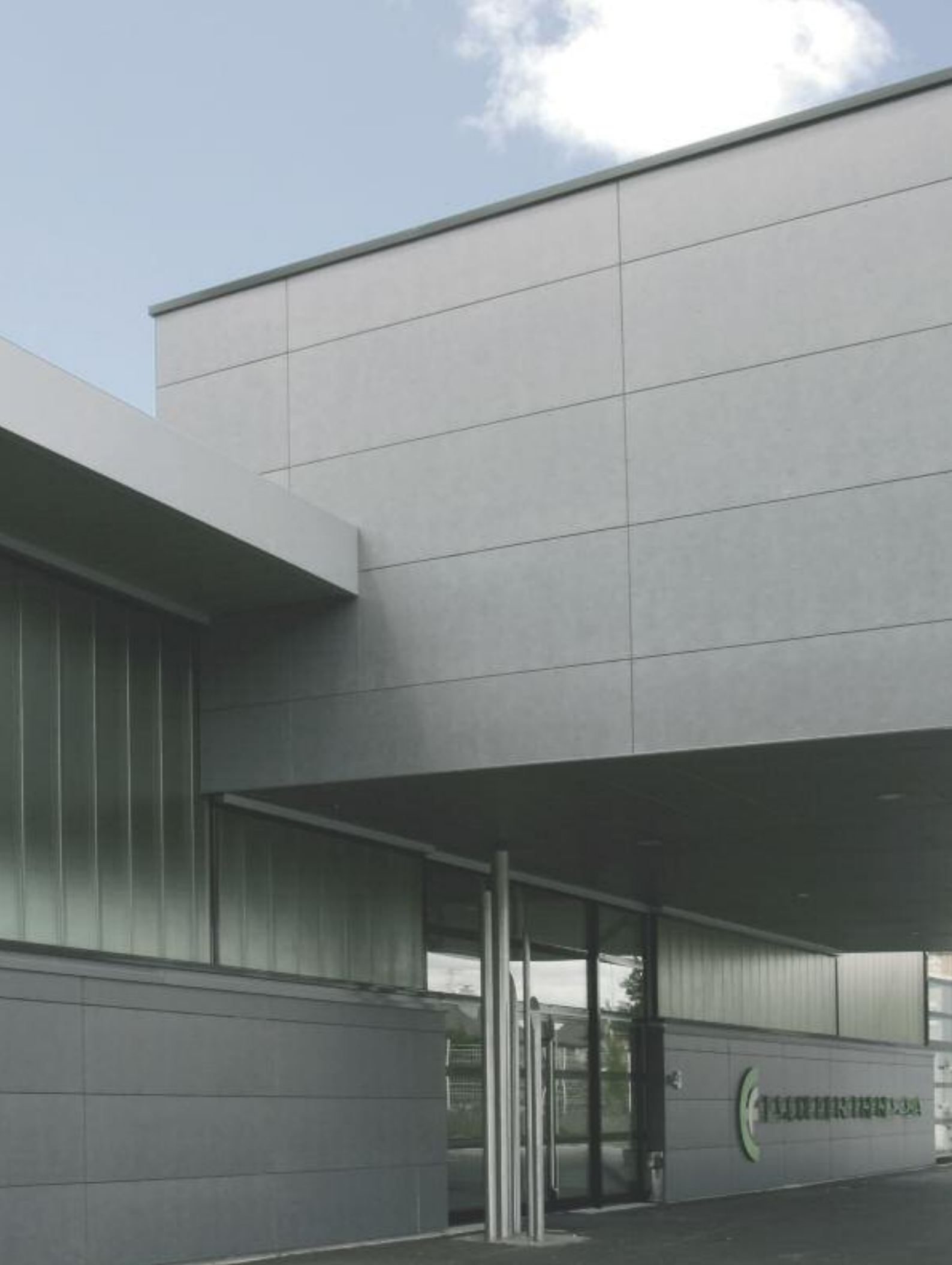
Usine Escoffier, Amphion (74) Architecte : Alain Daragon
